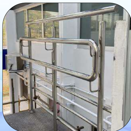
CORRIMÃO PNE COM GUARDA CORPO
