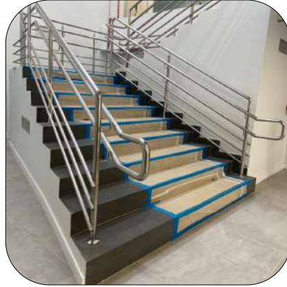
CORRIMÃO PNE COM GUARDA CORPO DE INOX
