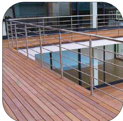
GUARDA CORPO COM CONTRAVENTAMENTO
