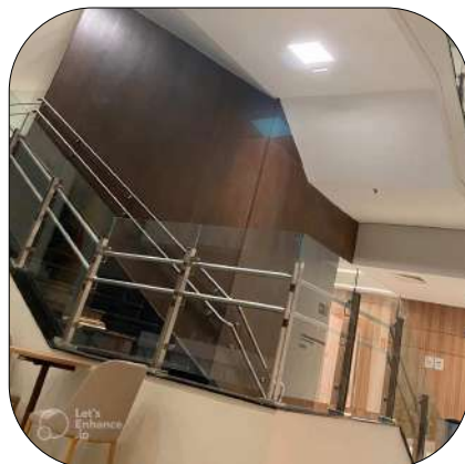
GUARDA CORPO DE VIDRO COM CORRIMÃO DE PAREDE
