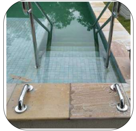
BARRA DE APOIO PARA TRANSFERÊNCIA
